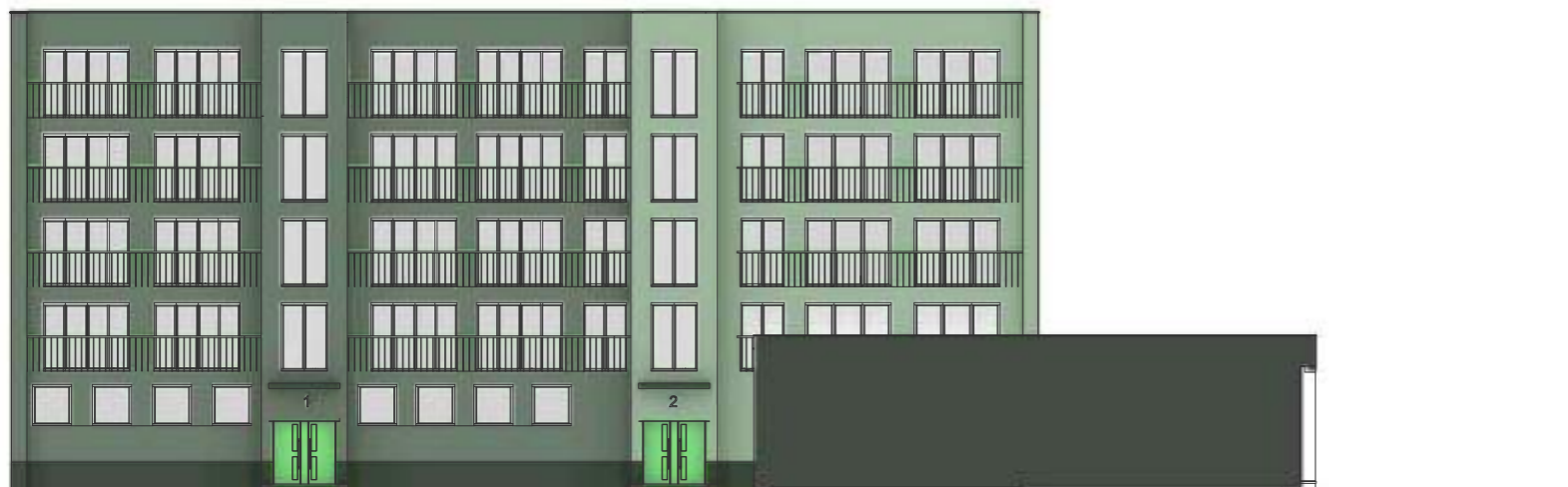
Originalus daugiabučio fasadas – šiaurinė pusė
